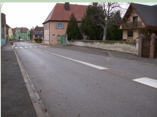
L'arrêt de bus côté impair se fait sur un espace aménagé hors chaussée avec un rétrécissement du trottoir. Côté pair il se fait sur la chaussée. Les hauteurs des trottoirs sont de 6cm.
