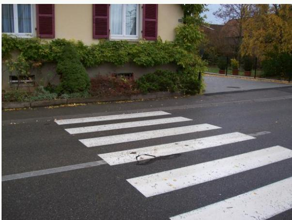
Le trottoir de chaque côté à une hauteur de 6 cm et une largeur inférieure à 1 m.
